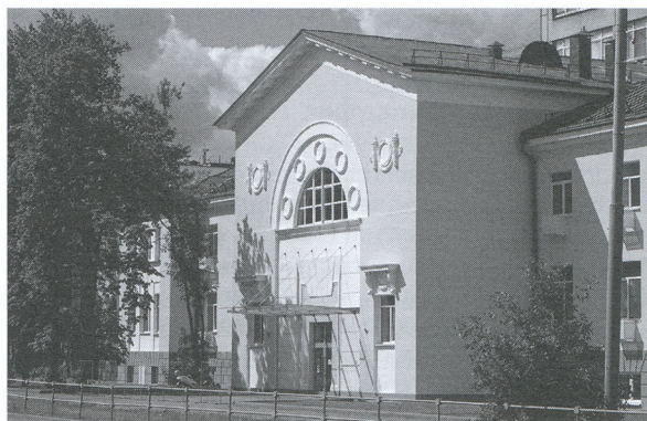
Главный фасад по Окружному проезду. Фотография автора, 2020 г. Фрагмент
