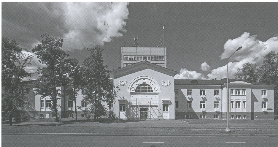
Главный фасад по Окружному проезду. Фотография автора, 2020 г.
