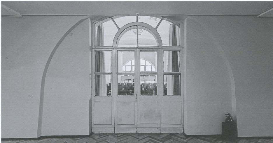
Сохранившееся в интерьере столярное заполнение балконной двери конференц-зала. Вид со стороны несохранившегося балкона. Фотография автора, 2020 г.
